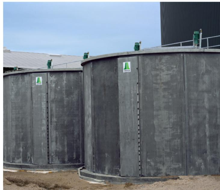
BG2 Decke - Cuve avec plafond en béton
